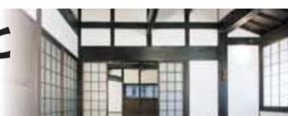
古民家がそうであるように、かつての日本の住宅は、柱がむき出しになつた真壁に、漆喰や土壁等、現場で水を使って仕上げる「湿式工法」で壁を仕上げるのが一般的でした。しかし、戦後の「安く、早く、大量に」住宅が求められた頃から、柱を板で覆い隠し、石膏ボード等の下地に糊でクロスを貼つていぐ乾式工法が普及し始めます。工期の短縮やコストの安さ、施工のしやすさから広く受け入れられ、現在ではほとんどの住宅がこの乾式で仕上げられています。
